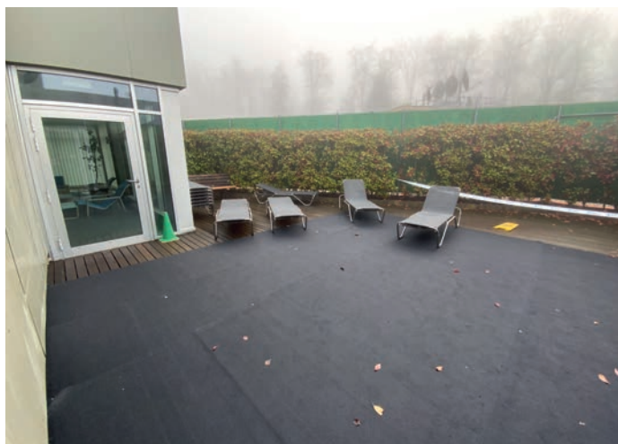
Aktuelle Situation des aussenliegenden Ruhebereichs (Saunagarten); Stand 04/2024
